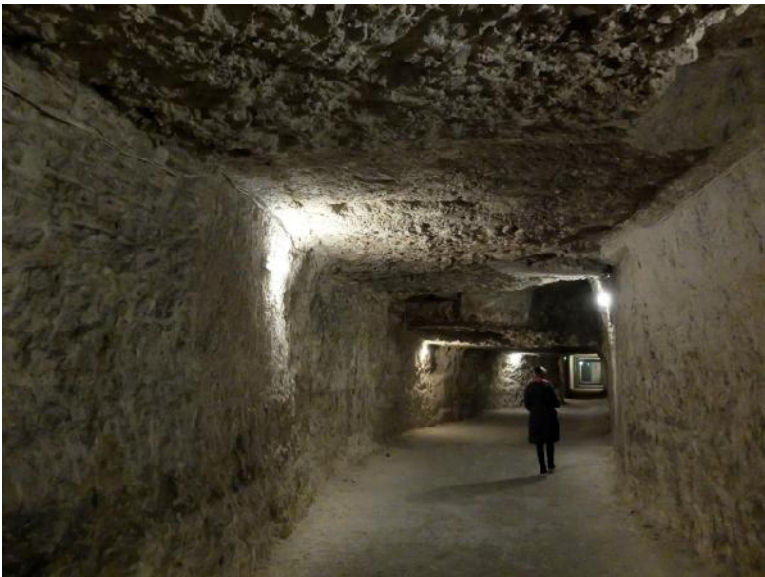
Beskyttelsesrummet består af lange gange, hvor der var opstillet køjesenge.
