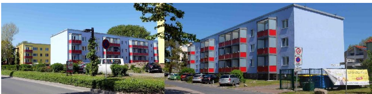
Gammelt østtysk betonbyggeri som er moderniseret og opfrisket med lidt farve.
