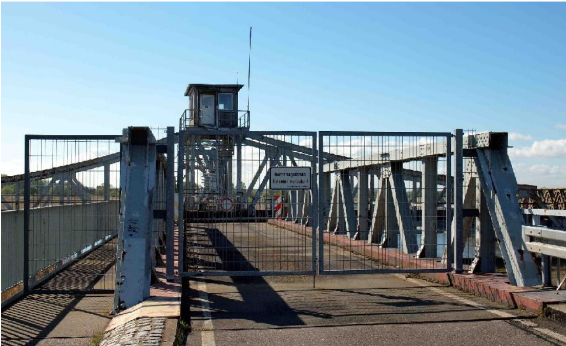
Den oprindelige Meiningenbrücke var først jernbanebro og blev senere ombygget til vejbro.
